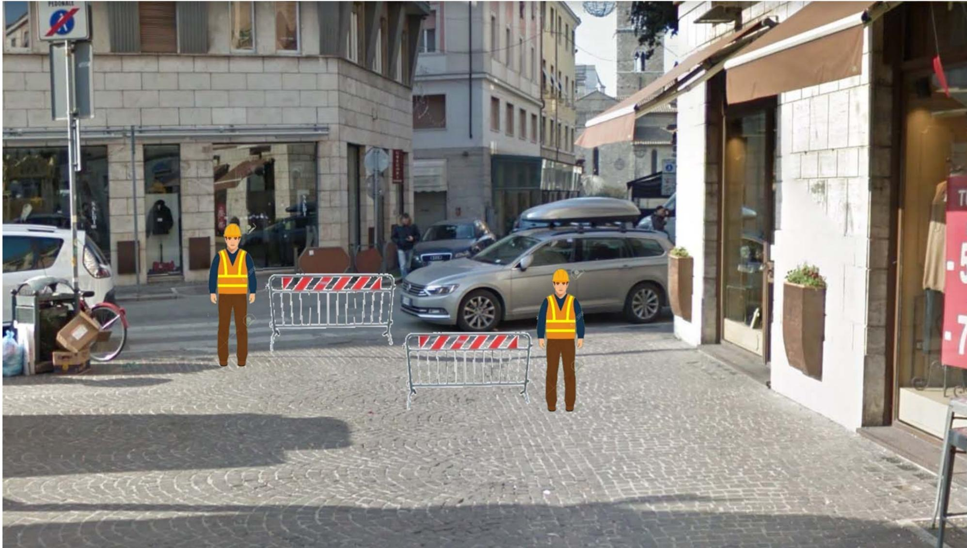
Si è optato per una misura di prevenzione con transenne (con due Safety) piuttosto che con un'autovettura in quanto quello specifico spazio è individuato come via di fuga verso un luogo sicuro (un'autovettura avrebbe impedito fisicamente il passaggio delle persone) e perché sono presenti le strisce pedonali di attraversamento di Via 1° Maggio.
