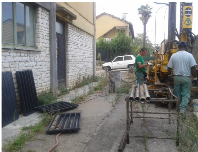
foto 1- ubicazione sondaggio S1
