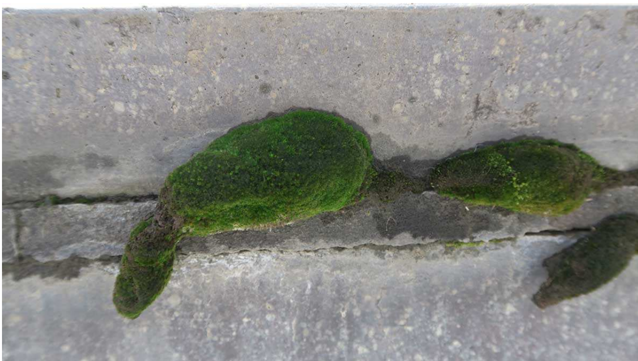
12. Presenza di vegetazione in corrispondenza delle fughe tra i giunti in porfido.
