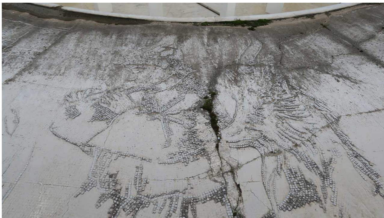
2. Particolare del segno Zodiacale del Capricorno: incrostazioni, lesioni e presenza di biodeteriogeni
