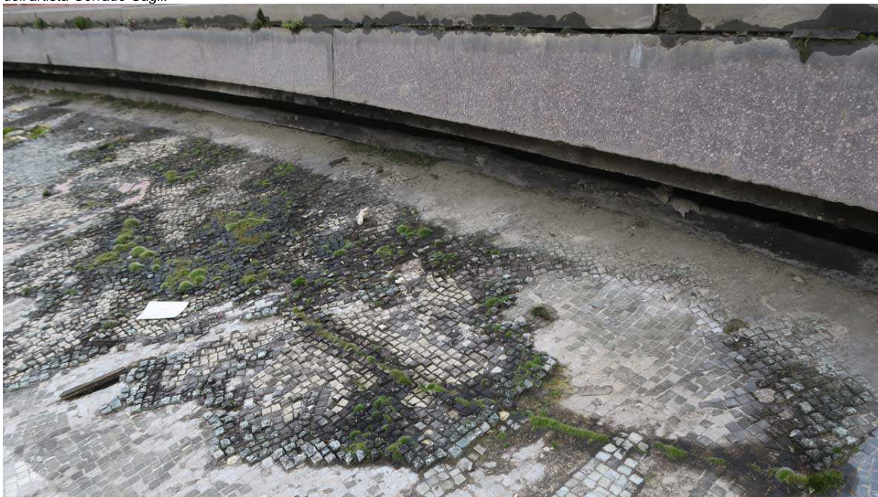
7. Presenza di patina biologica in corrispondenza del segno zodiacale della Bilancia
