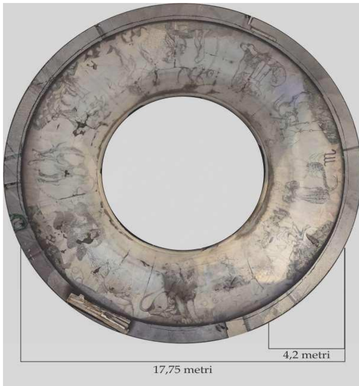
Fig.2 - Ortofotografia a bassa risoluzione della fontana nel 2013. Evidente il cattivo stato di conservazione, con lesioni evidenti e lacune diffuse, e la ridotta leggibilità.
