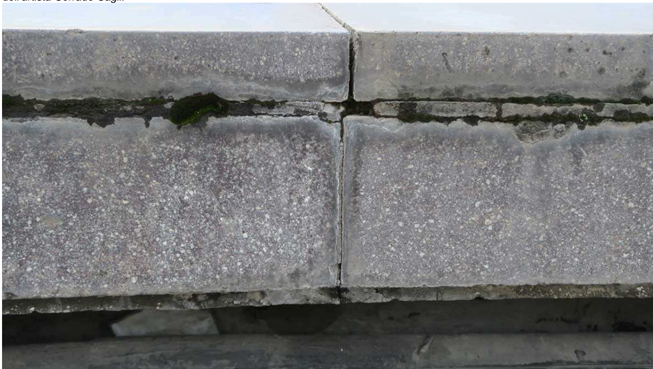
11. Corona circolare in porfido del gleno prospiciente il catino: depositi superficiali, patina biologica, decoesione
