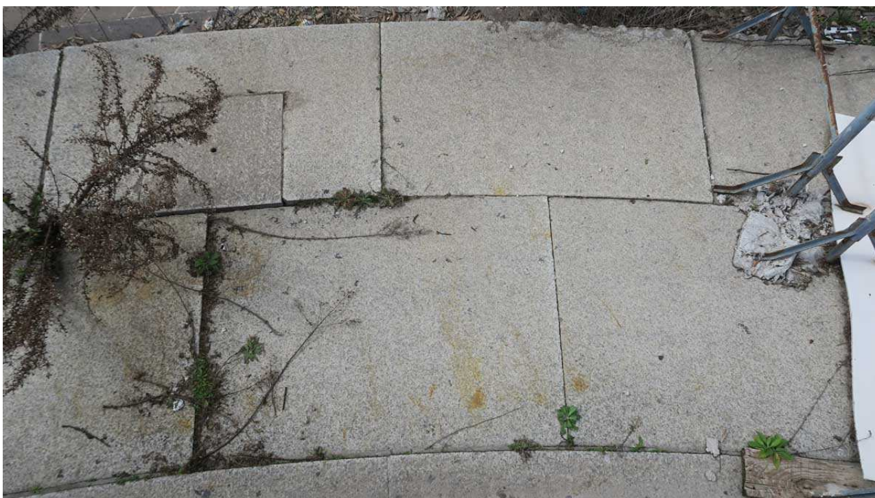
10. Pavimentazione in granito rosa di baveno: presenza di vegetazione, depositi superficiali, ossidi di ferro
