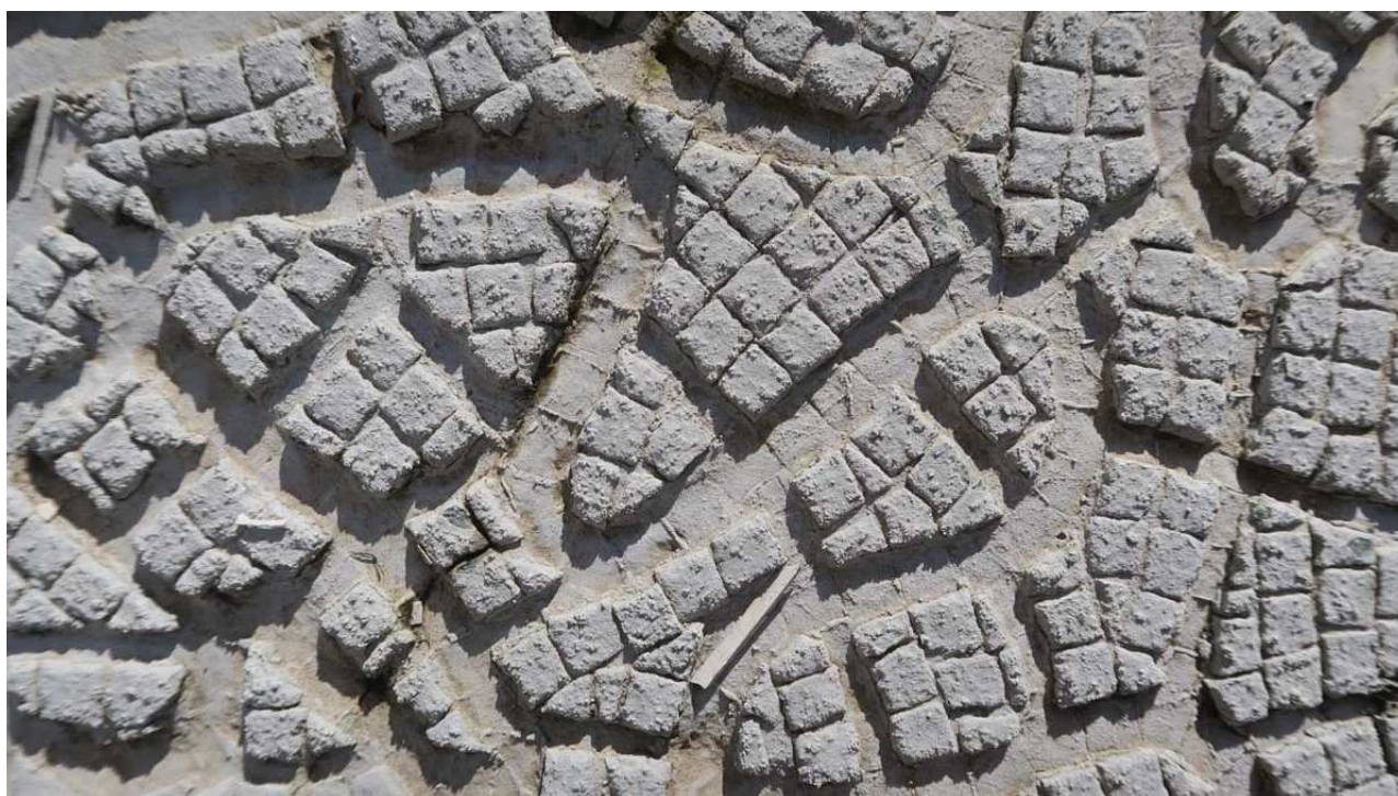
4. Concrezioni calcaree in corrispondenza di degrado selettivo delle tessere
