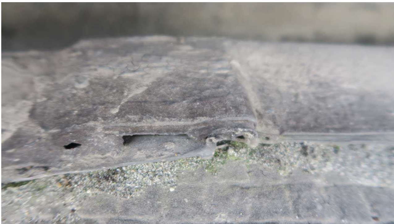
14. Guaina a protezione del perimetro superiore dei mosaici
