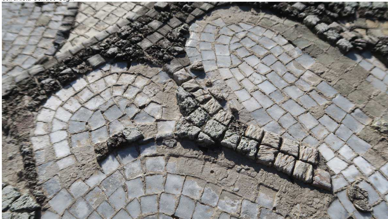
5. Degrado selettivo delle tessere (in rilievo le tessere silicatiche)
