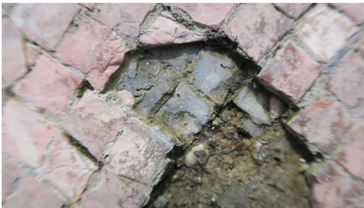
6. Distacco delle tessere dallo strato di allettamento in corrispondenza del Segno zodiacale del Cancro
