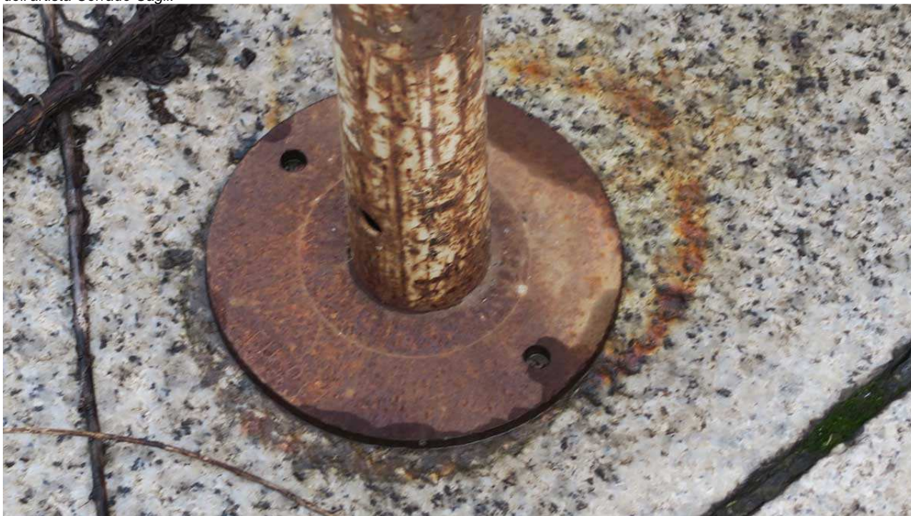
13. Assorbimento di ossidi di ferro in corrispondenza delle basette arrugginite del ponteggio della recinzione
