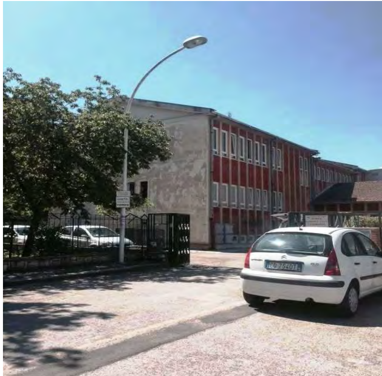
Figura n. 2: accesso principale su Via Vodice.
