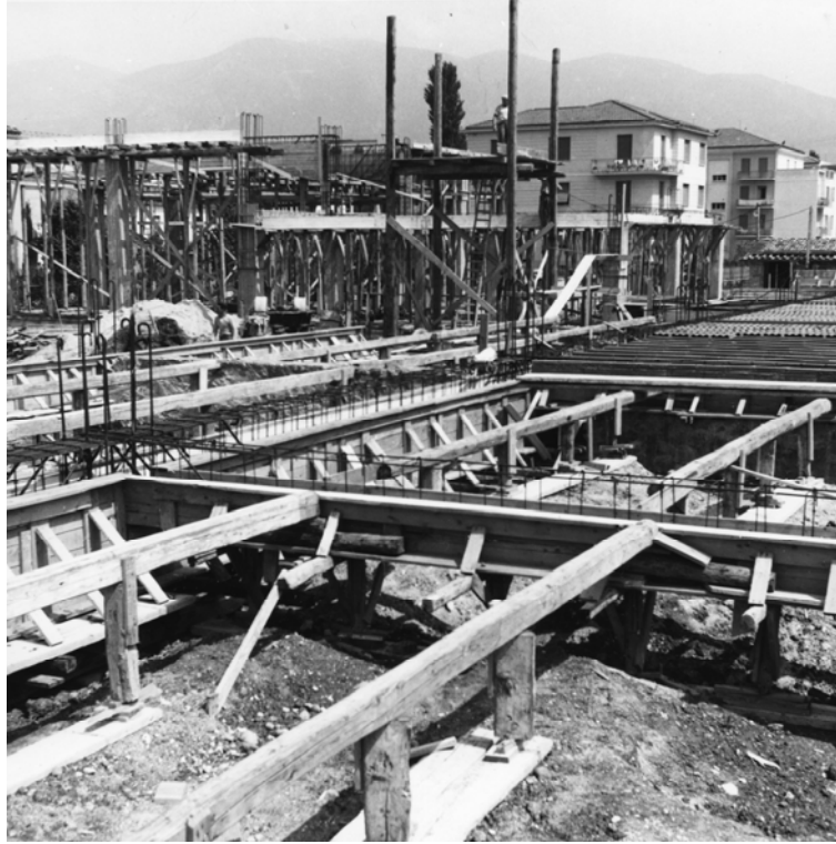
Figura n.9: realizzazione della struttura portante, 2 maggio 1962.
