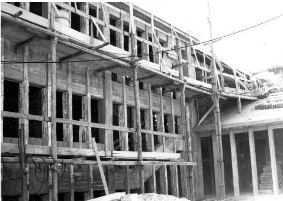
Figura n.12: Realizzazione della struttura in pilastri e pilastrini, vista esterna.
