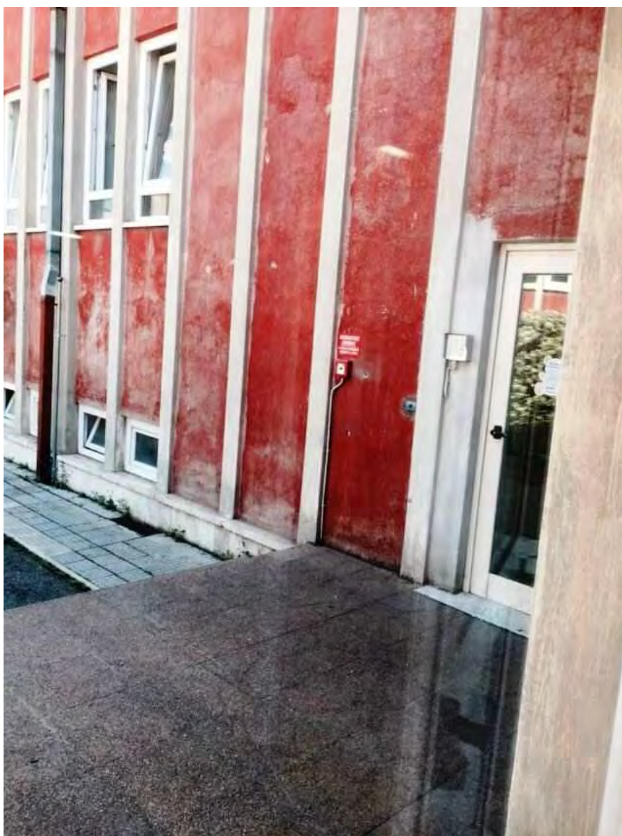
Figura n.14: ingresso principale alla scuola materna.
