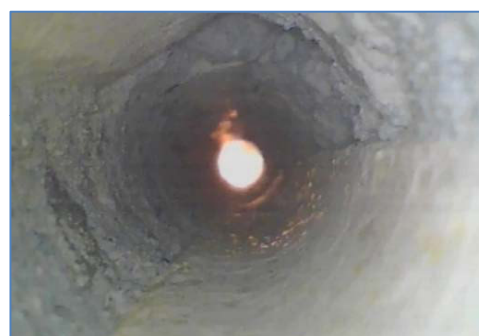
EM6.2 - 15 cm da inizio foro, muratura in mattoni pieni
