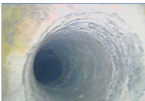
EM12.1 - inizio foro, muratura in mattoni pieni
