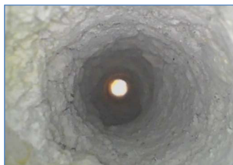
EM2.2 - 20 cm da inizio foro, muratura in pietra con piccole discontinuità
