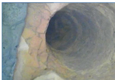
EM11.1 - inizio foro, muratura in mattoni pieni
