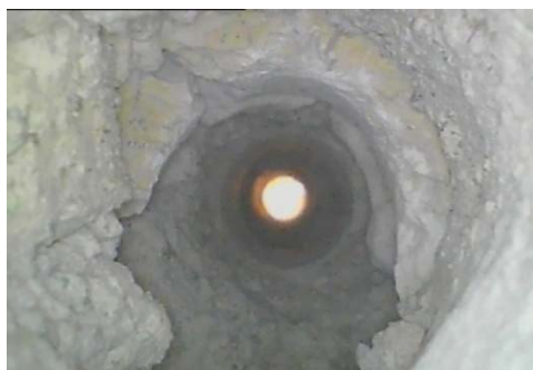
EM2.3 - 40 cm da inizio foro, muratura in pietra con piccole discontinuità
