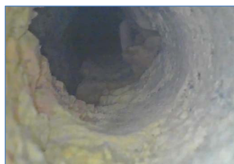
EM11.2 - 15 cm da inizio foro, muratura in mattoni pieni
