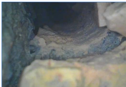
EM12.3 - 30 cm da inizio foro, muratura in mattoni pieni
