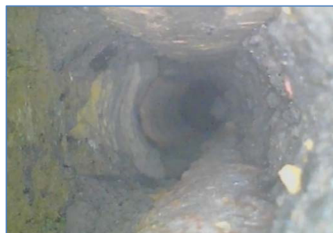
EM12.2 - 15 cm da inizio foro, muratura in mattoni pieni
