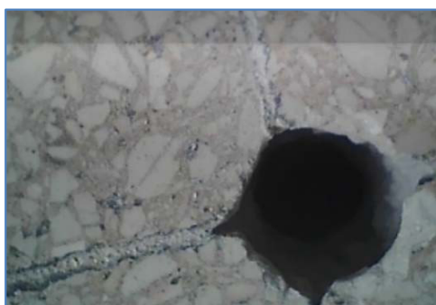
ES13.1 - inizio foro, estradosso solaio, pavimentazione
