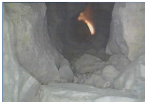
EM9.2 - 15 cm da inizio foro, muratura in pietra con piccole discontinuità
