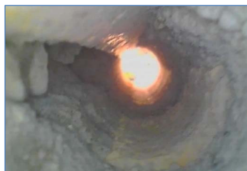
EM6.3 - 30 cm da inizio foro, muratura in mattoni pieni
