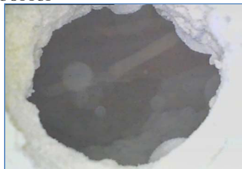
ES13.2 - 4 cm da inizio foro, soletta e massetto
