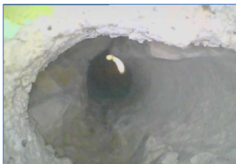
EM9.1 - inizio foro, muratura in pietra con piccole discontinuità
