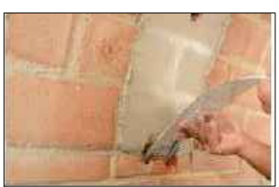
b. Applicazione del tessuto in acciaio galvanizzato
