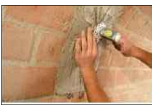
c_Installazione del connettore
