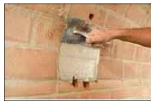
a_Esecuzione dei fori e applicazione del primo strato di malta
