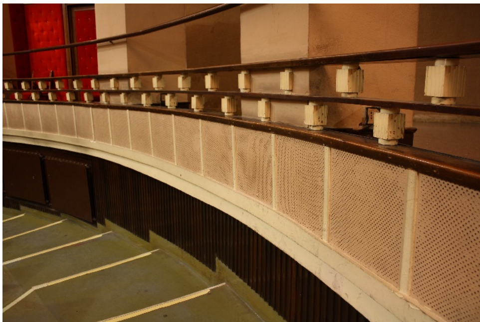
Foto 3: Pannelli forati su parapetti
