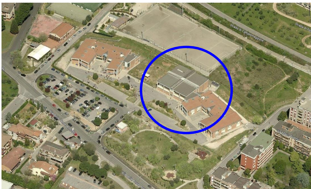
Vista aerea del complesso.
