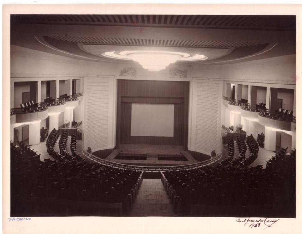
Vista dell'interno dalla galleria della nuova sala 1948 con i palchetti originari poi eliminati dal gestore.
