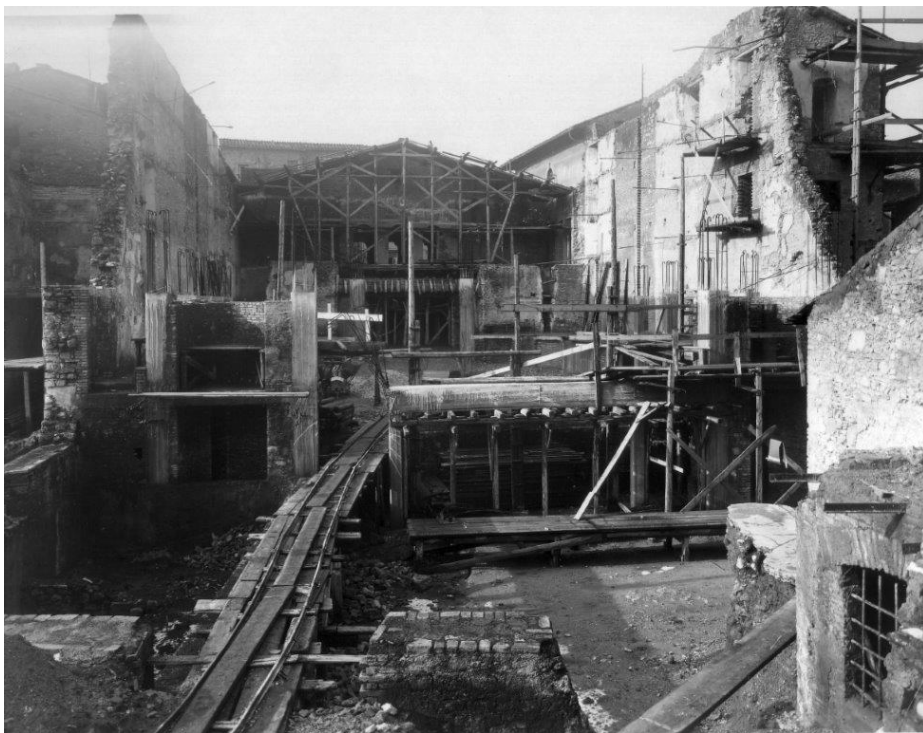
Immagine del cantiere del 1947-48 Vista dalla nuova torre scenica
