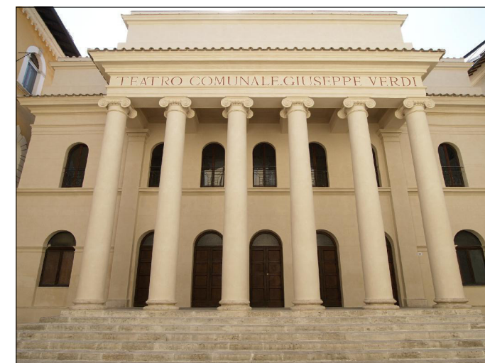
VISTA FACCIATA PRINCIPALE SU CORSO VECCHIO
