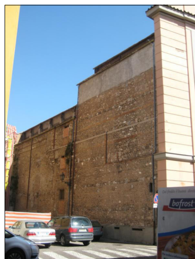
VISTA FACCIATA ANGOLO VIA SANT'AGAPE
