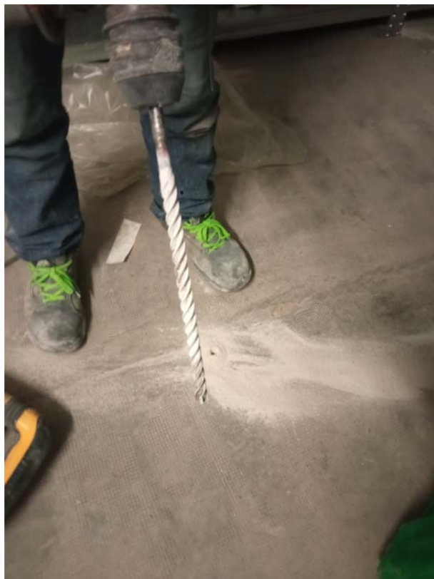
Figura 73: Saggio per individuare armatura soletta piano interrato
