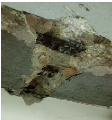
Figura 64: Presenza di barre di acciaio Rumi a sezione quadrata all'intradosso della trave posta tra mensa e cucina
