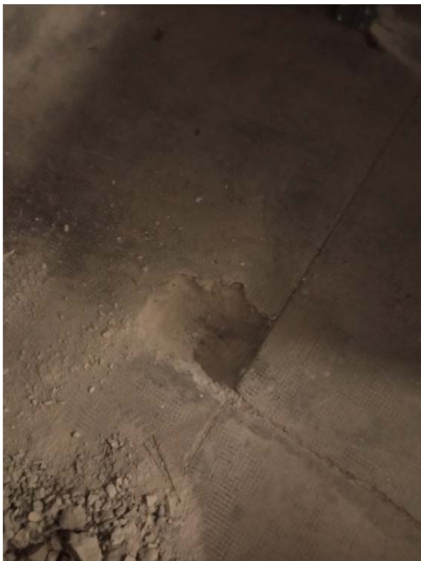
Figura 73: Saggio per individuare armatura soletta piano interrato
