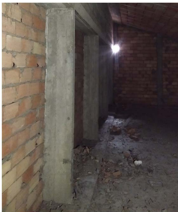
Figura 66: Apertura nelle tramezzature per accesso al sottotetto non accessibile
