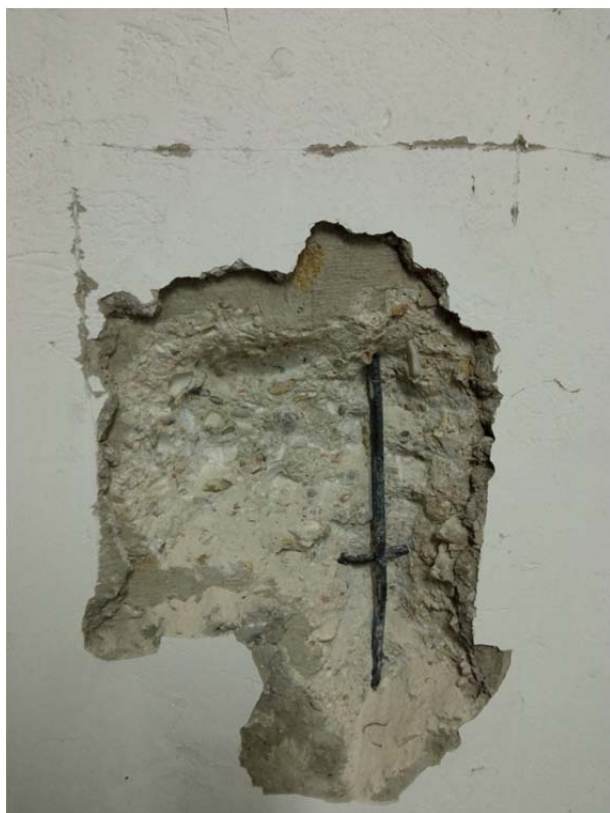
Figura 71: Saggio per individuare armatura muro controterra piano interrato
