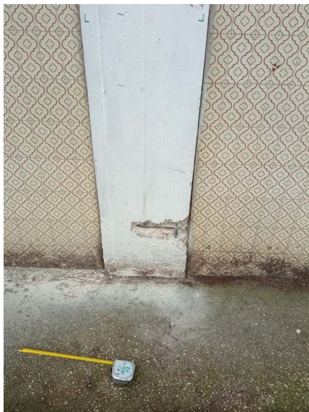
Figura 69: Saggio su pilastro allineamento tra palestra e deposito
