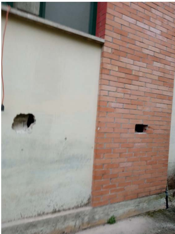
Figura 77: Tamponamenti con camere d'aria e saggi per individuare geometrie e armature pilastri - Corpo B
