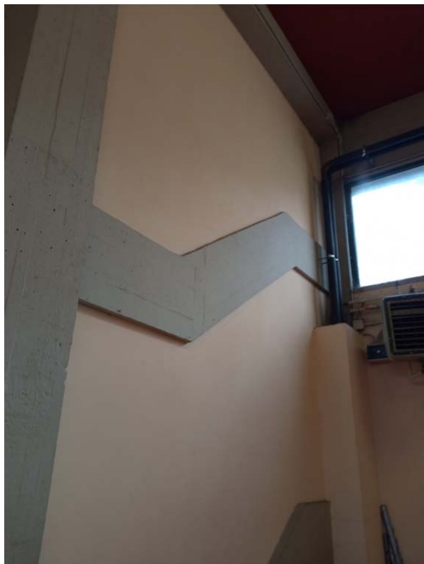
Figura 59: Presenza di trave ginocchio a creare irregolarità strutturale Figura 60: Espulsione copriferro sulla faccia contrapposta alla trave ginocchio
