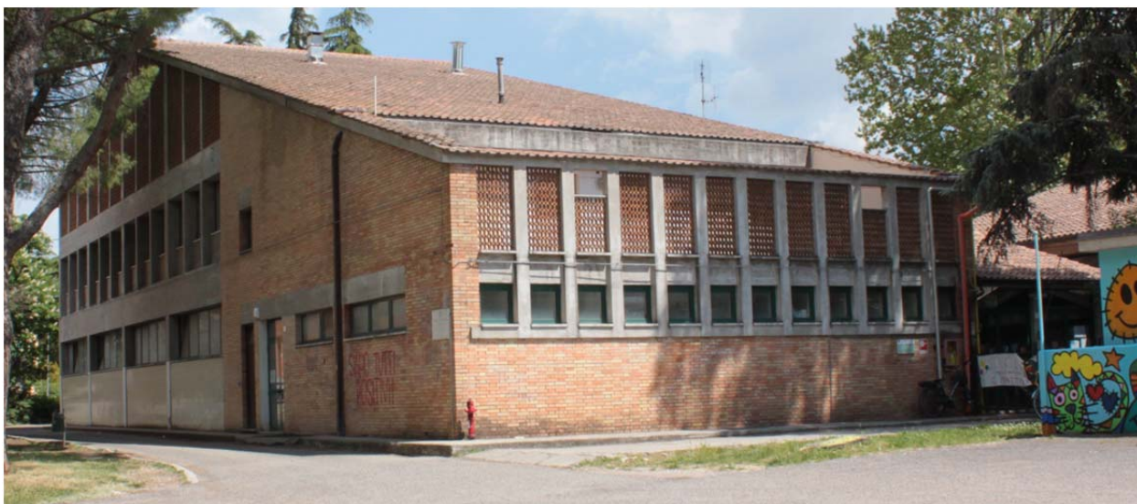
Figura 75: Presenza di mandolati in laterizio - Edificio C
