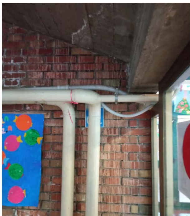
Figura 61: Infiltrazioni d'acqua sulle pareti portanti e all'interno degli edifici tipo A Figura 62: Infiltrazioni d'acqua e espulsione di copriferro in corrispondenza degli impluvi del connettivo
