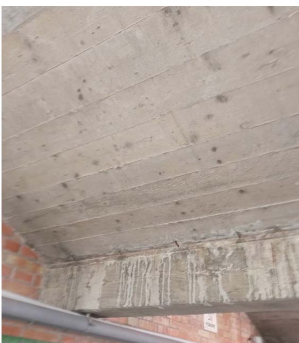
Figura 61: Infiltrazioni d'acqua sulle pareti portanti e all'interno degli edifici tipo A Figura 62: Infiltrazioni d'acqua e espulsione di copriferro in corrispondenza degli impluvi del connettivo
