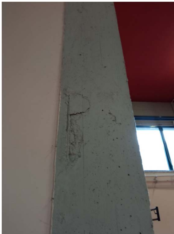
Figura 59: Presenza di trave ginocchio a creare irregolarità strutturale Figura 60: Espulsione copriferro sulla faccia contrapposta alla trave ginocchio
