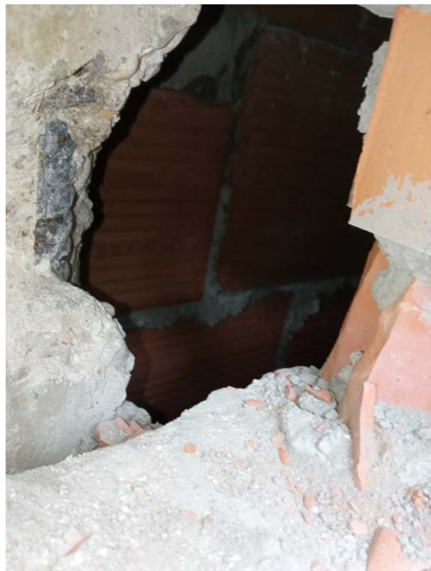
Figura 77: Tamponamenti con camere d'aria e saggi per individuare geometrie e armature pilastri - Corpo B
