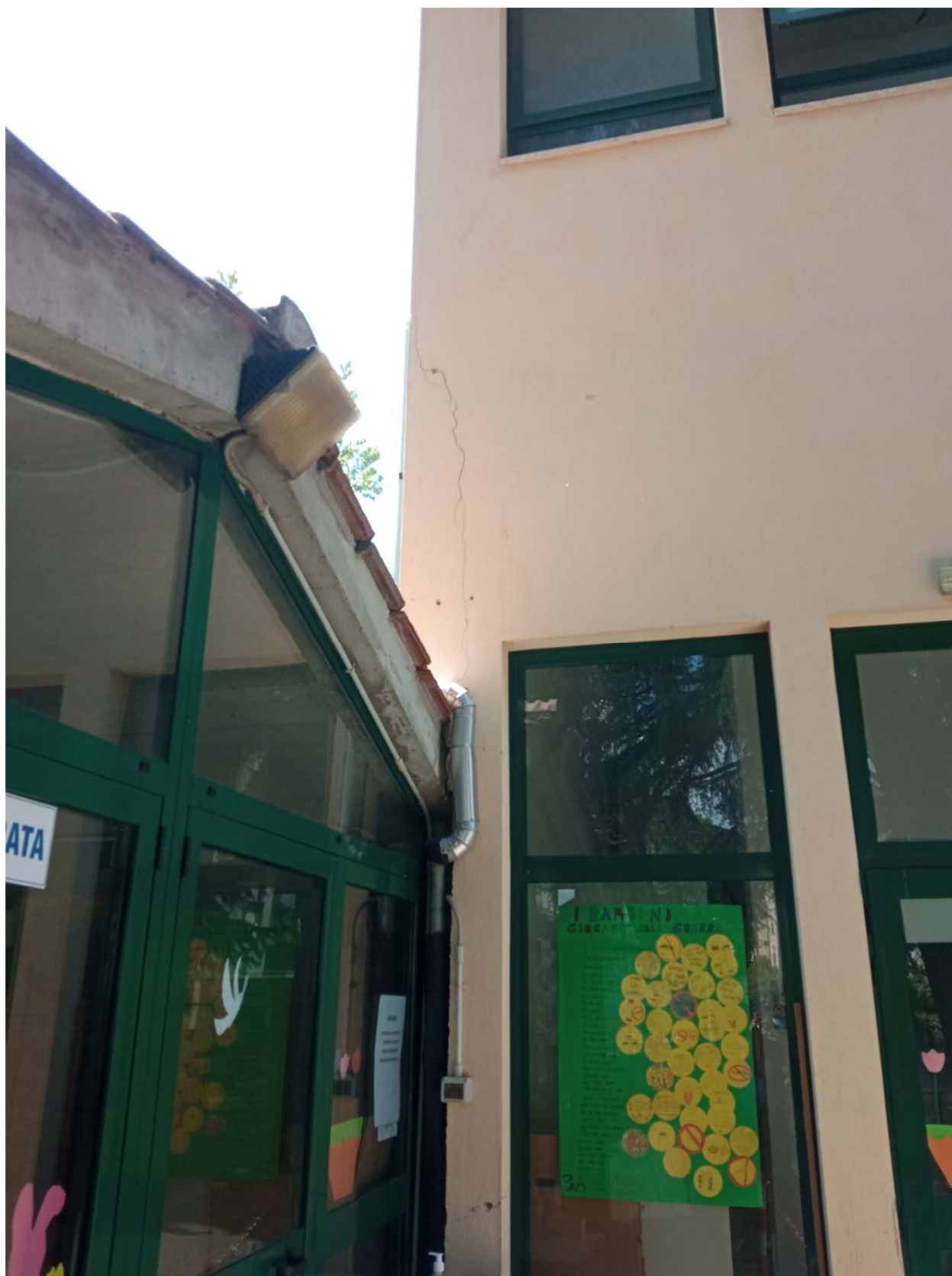
Figura 50: Lesione su tamponamento corpo scale
