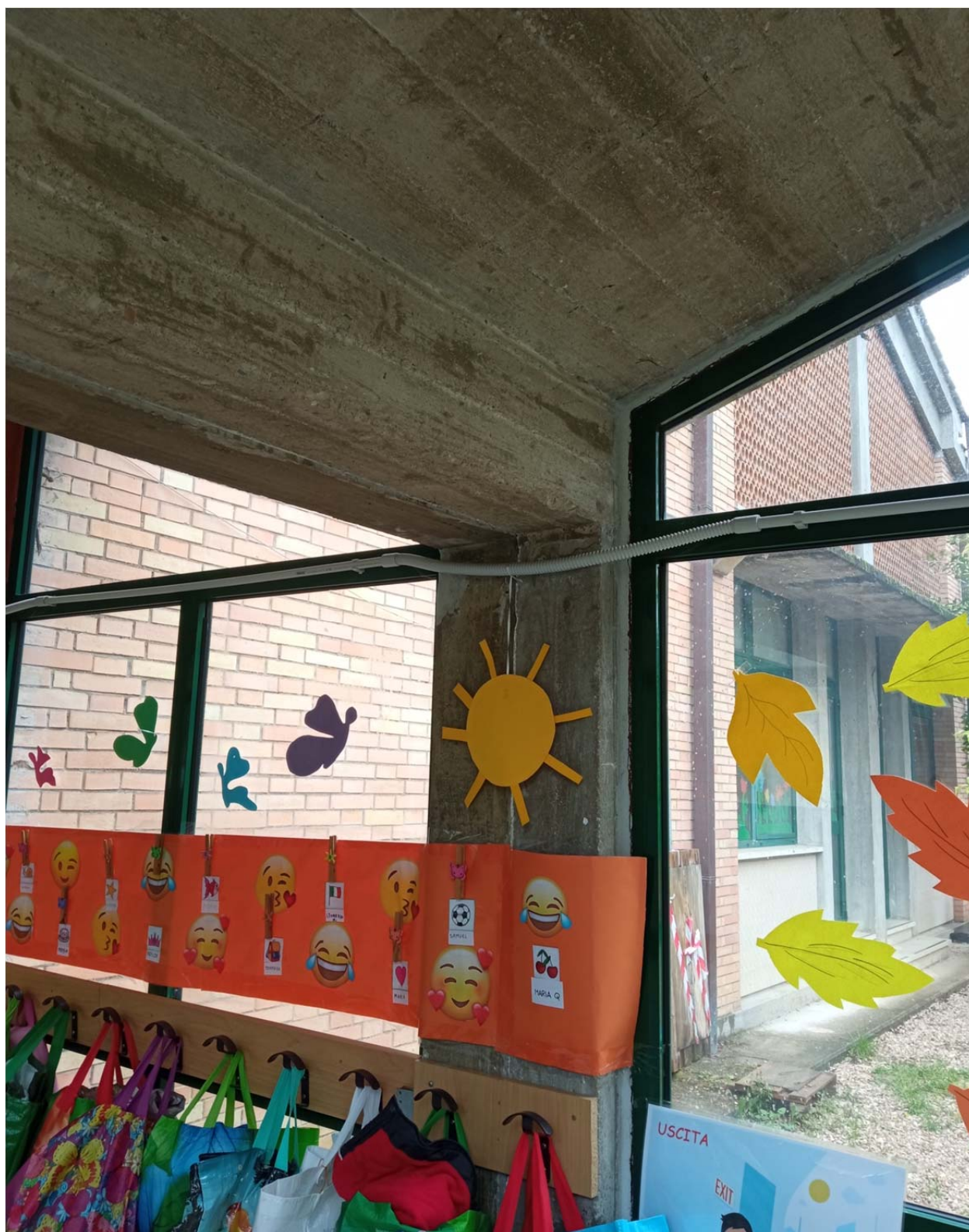
Figura 56: Assenza giunto sismico tra porzione di corridoio connesso al Corpo B e quella connessa ai Corpi A-C
