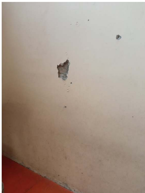
Figura 71: Saggio per individuare armatura muro controterra piano interrato
