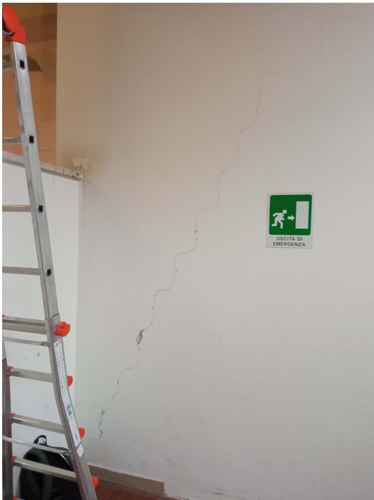
Figura 63: Lesione diagonale su tramezzatura
