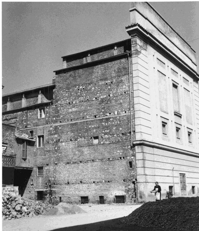
Facciata posteriore del teatro su Largo Sant'Agape all'epoca della sua ricostruzione
