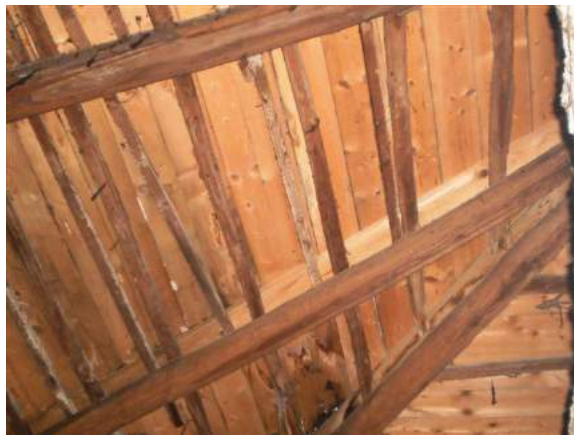
Copertura in legno e tavolato: vista dell'intradosso e dall'estradosso
