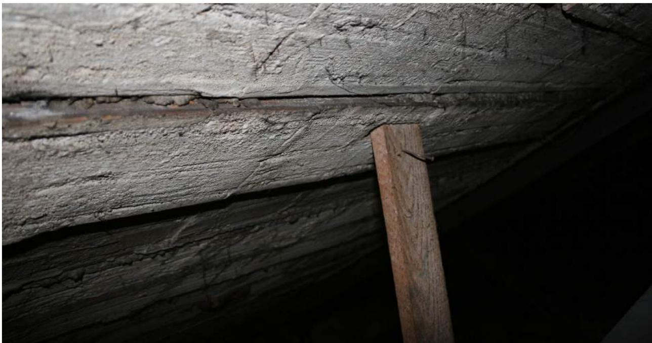
Nel certificato di collaudo tecnico del 4 Aprile 1949 il collaudatore recitava: *"Si è anche esaminata la struttura portante del tetto, costituita da incavallature in ferro sostenenti travetti SAP da 8 cm e si è riscontrato che alcuni di questi, probabilmente perché posti in opera non sufficientemente stagionati o per esser stati caricati troppo presto, presentano alcune deformazioni per cui sarebbe consigliabile la loro sostituzione"*.
