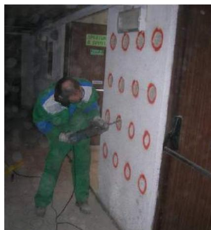
Fasi di misura con l'ausilio di martello strumentato (sx), rimozione intonaco nei punti di misura (dx).
